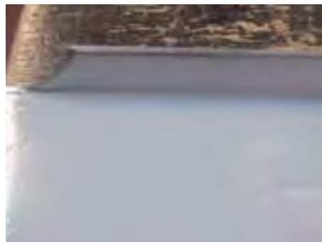
Beklebte Schare bei einer Doppelstehfalzdeckung
