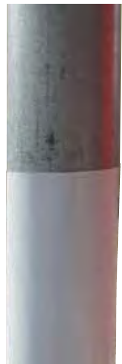
Folie schützt Fallrohr (z.B. bei Putzarbeiten)
